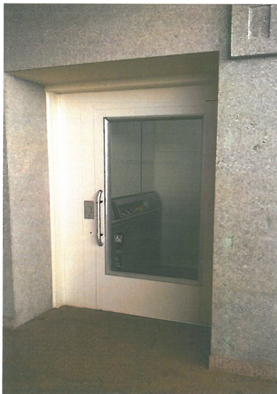
Rys.2. Winda - widok w przejściu podziemnym.
